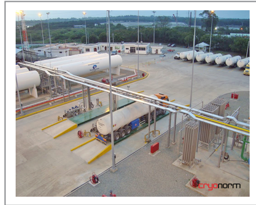
DUAL LNG TRUCK LOADING BAY AT 200 TPD LNG PLANT
