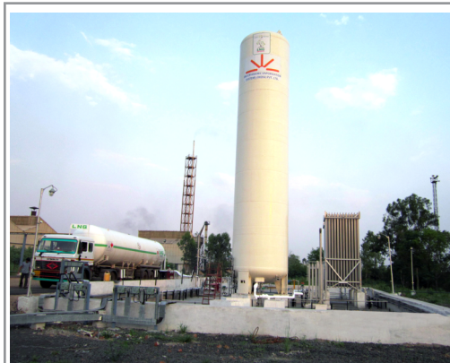
LNG RE - GAS INSTALLATION EPC PROJECT - BOOM
